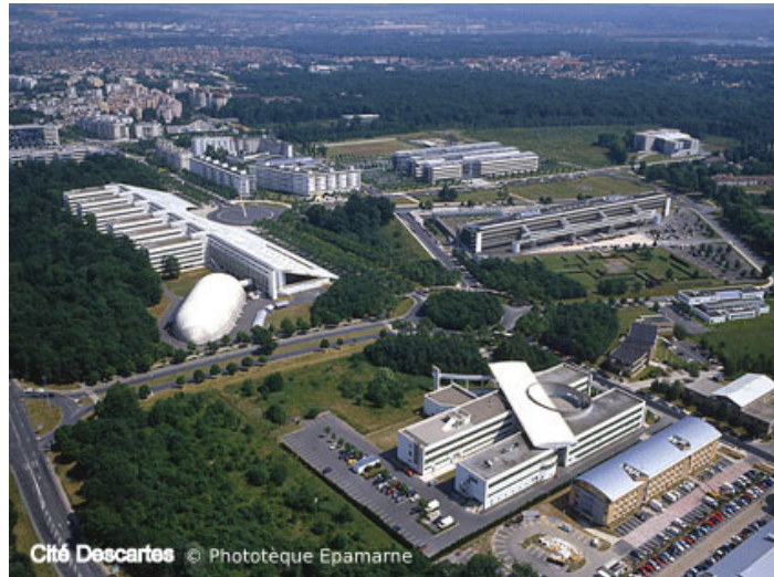
Figure 1 - Vue aérienne de la Cité Descartes (77)
