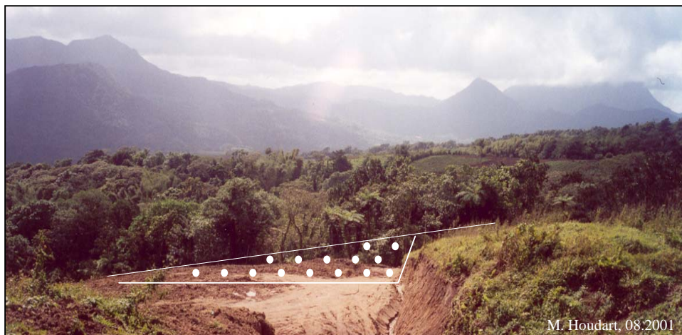
Photographie 3. Modelage de terrain pour réduire les pentes Trianon. hauteurs du bassin versant de rivière Noire
