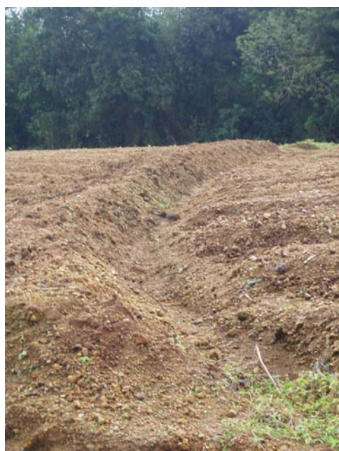
Photographie 5. Drain ouvert sur parcelle labourée pour écouler l'eau vers la ravine (au fond) et la trace (prise de vue) Savane Moulinier
