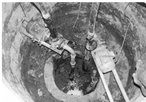
Photographie N°7: Un puits sec électrifié prolongé par 2 forages à bras. (Cliché S.Feuillette, 1998)
