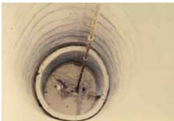
Photographie N°6: Un puits sec prolongé par un forage à Bras. (Cliché S.Feuillette, 1998)
